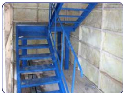
Установка лестницы внутри помещения или за пределами модульного здания
