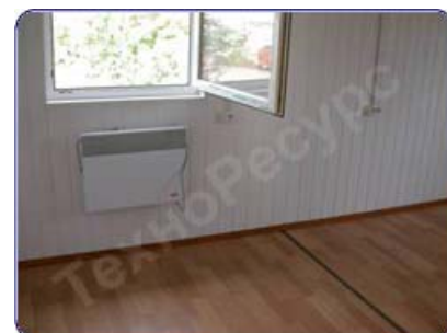
Установка электрических обогревателей и полной электропроводки в кабельканале (установка евророзеток, выключателей, щитов, автоматов, УЗО, различных светильников): конвектор 1,5 кВт с электронной выдержкой температуры
