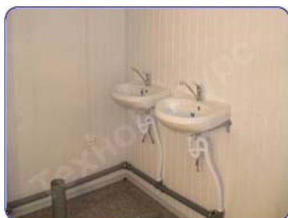
Установка раковин и разводки канализации
