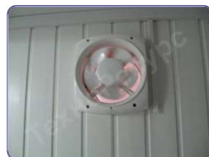
Установка приточных вентиляторов
