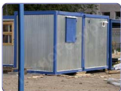
Установка металлических ставней на окна
