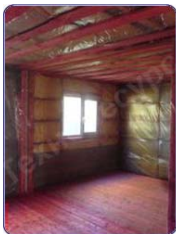
Обработка перекрытий внутри модульного здания огнебиозащитным составом
