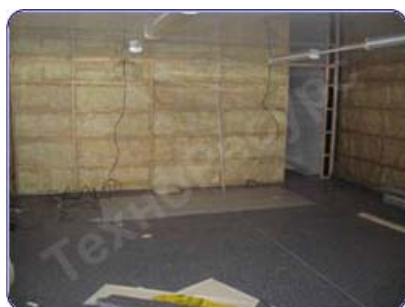
Установка дополнительного утепления внутри помещений.
